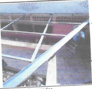
Foto 5: Cambio de estructura de corredor
