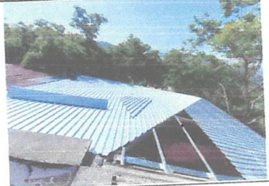
Foto 2: Cambio de estructura de corredor
