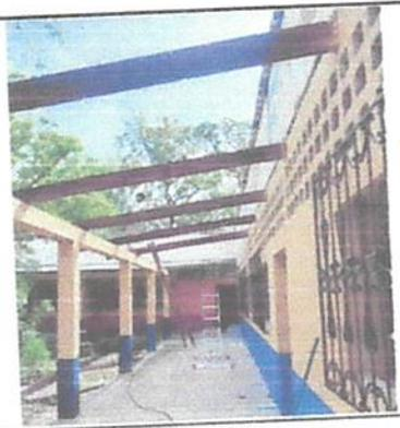
Foto 4: Cambio de estructura de corredor
